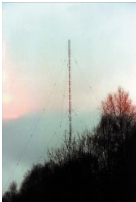
Der Sendemast von DCF39 in Burg bei Magdeburg Foto: DK8KW
