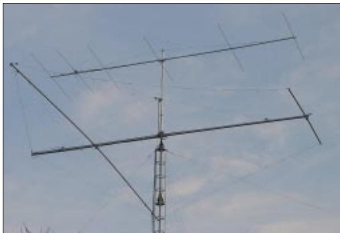
Bild 1: Die 7,20 m lange 6-Element-Yagi über der Kurzwellen-Logperiodic DLP-15
