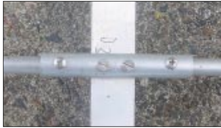
Bild 9: Befestigung der Parasitärelemente bei einem Vierkantboom
