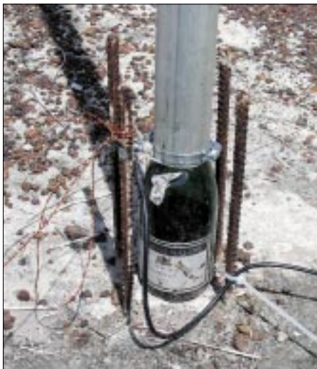
Fußpunkt der V80E auf dem Nachbargrundstück – Armierung als Erdnetz, Radials wurden dann aber trotzdem noch ausgelegt.
