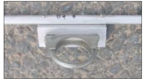
Bild 10: Haltewinkel mit Auspuffschelle für Tragrohre aus Rundmaterial
