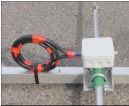
Bild 8: Fertig montiertes Mittelstück in der Antenne
